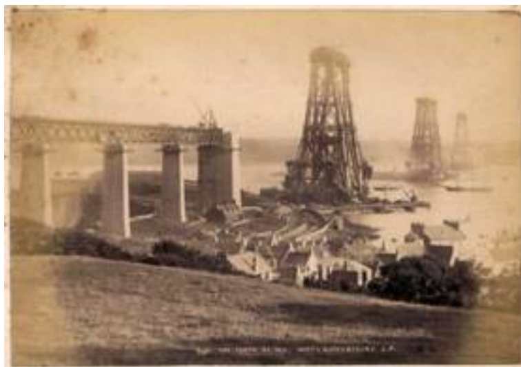
Рис. 3. Строительство моста Форт
